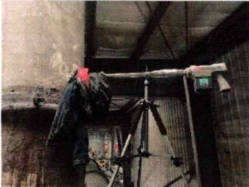
图 22 1#立式喷涂酸雾废气排气筒
