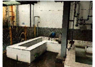
图 30 南铝废水二站排放口
