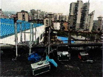
图 28 洗模中心碱雾排气筒
