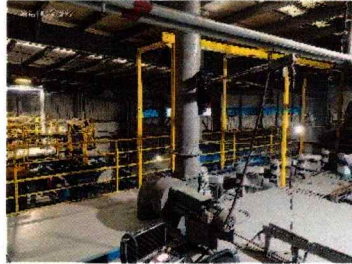
图 20 1#立式喷涂生产线固化炉
